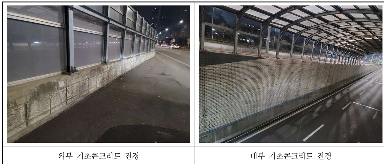
【사진 3.4.7】 기초콘크리트 전경
