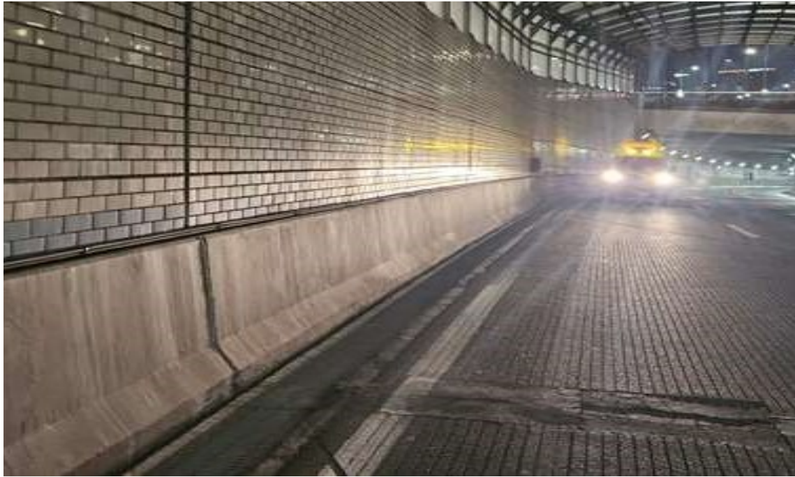
내부 배수시설 전경
