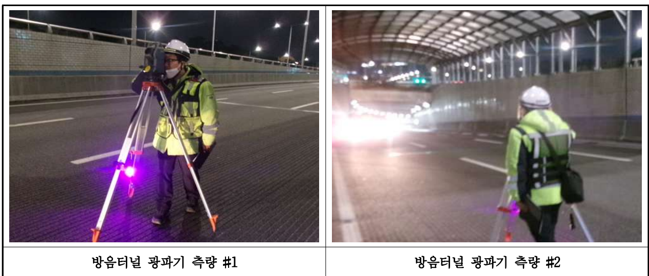
【사진 3.6.2】 광파기를 이용한 변위 · 변형 측량 현장사진
