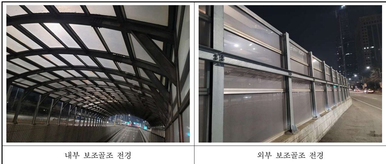
【사진 3.4.3】 보조골조 전경
