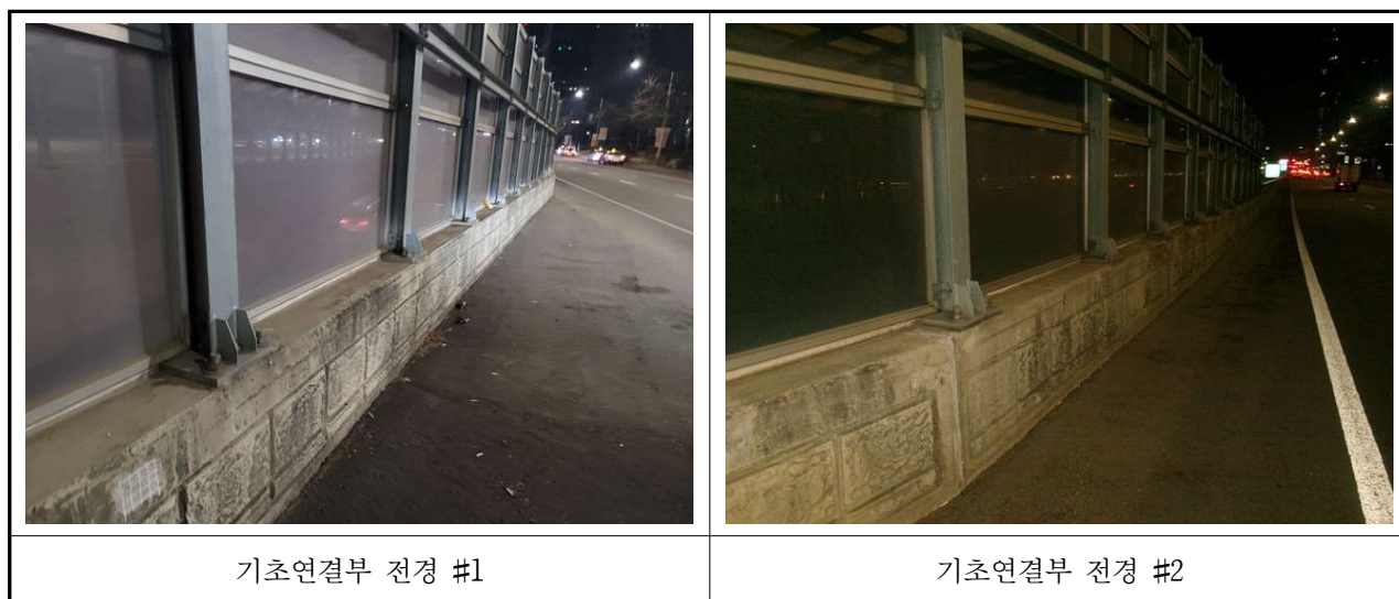
【사진 3.4.5】 기초연결부 전경
