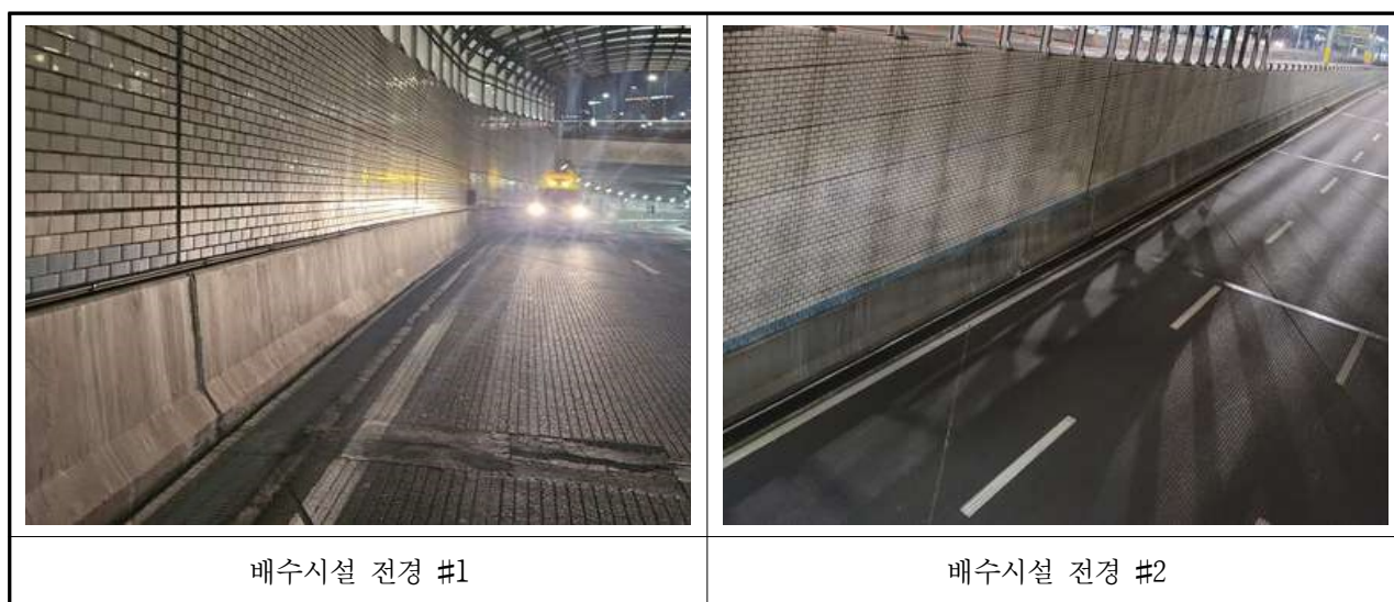
【사진 3.4.11】 배수시설 전경
